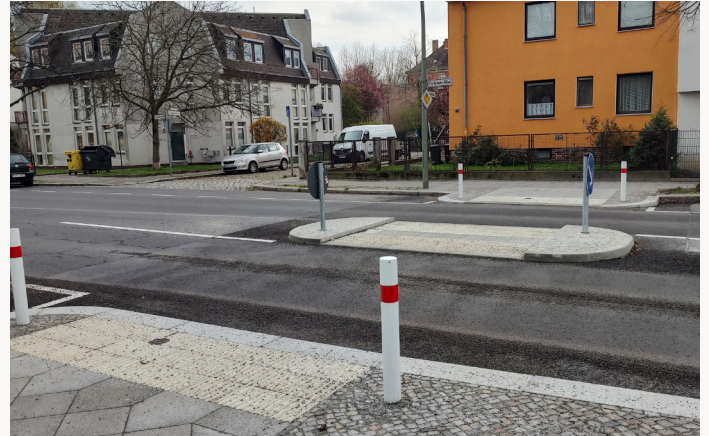
Neue Querungshilfe an der Ecke Semkensteig / Pankower Allee
